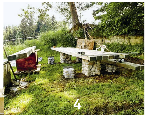
Montage der Holz-Balken (Tisch und Bänke) auf die versetzten Fundamente
