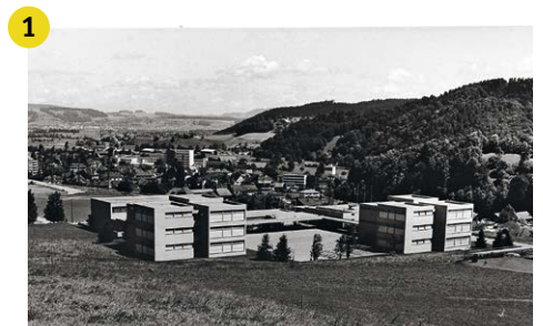
1967: Schulhaus Schlossfeld, Südansicht
