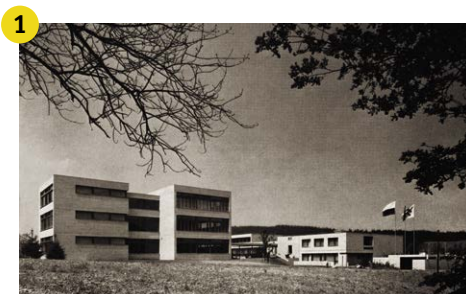
1967: Schulhaus Schlossfeld, Ostansicht
