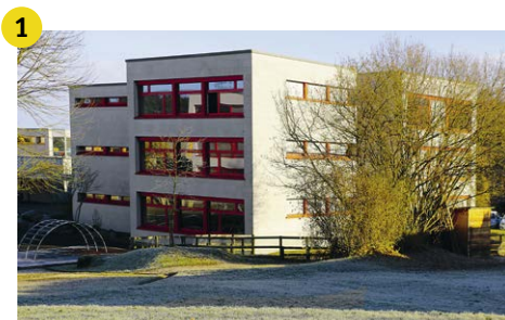
1967: Schulhaus Schlossfeld, Trakt B
