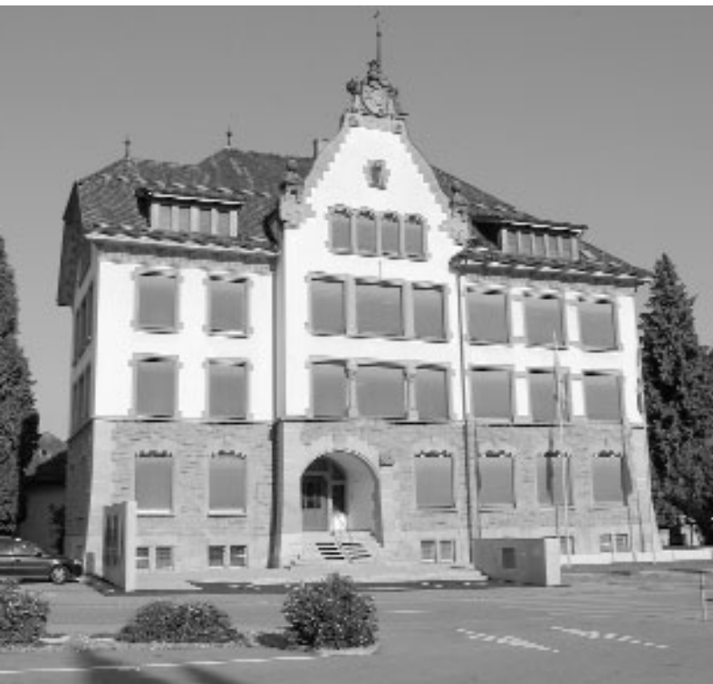
Ehemaliges Schulhaus Obertor (1908-1967), heute Verwaltungszentrum
