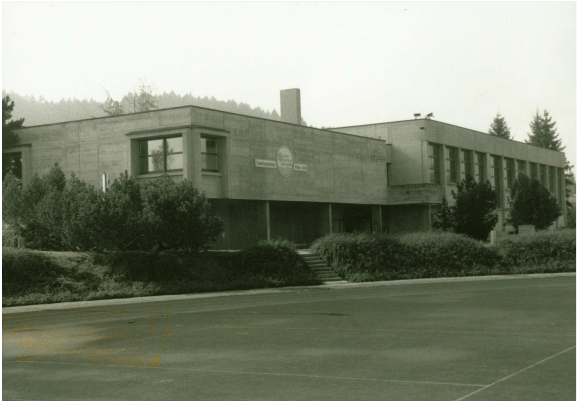
Bau des Sportzentrums und Hallenbad 1971/72
