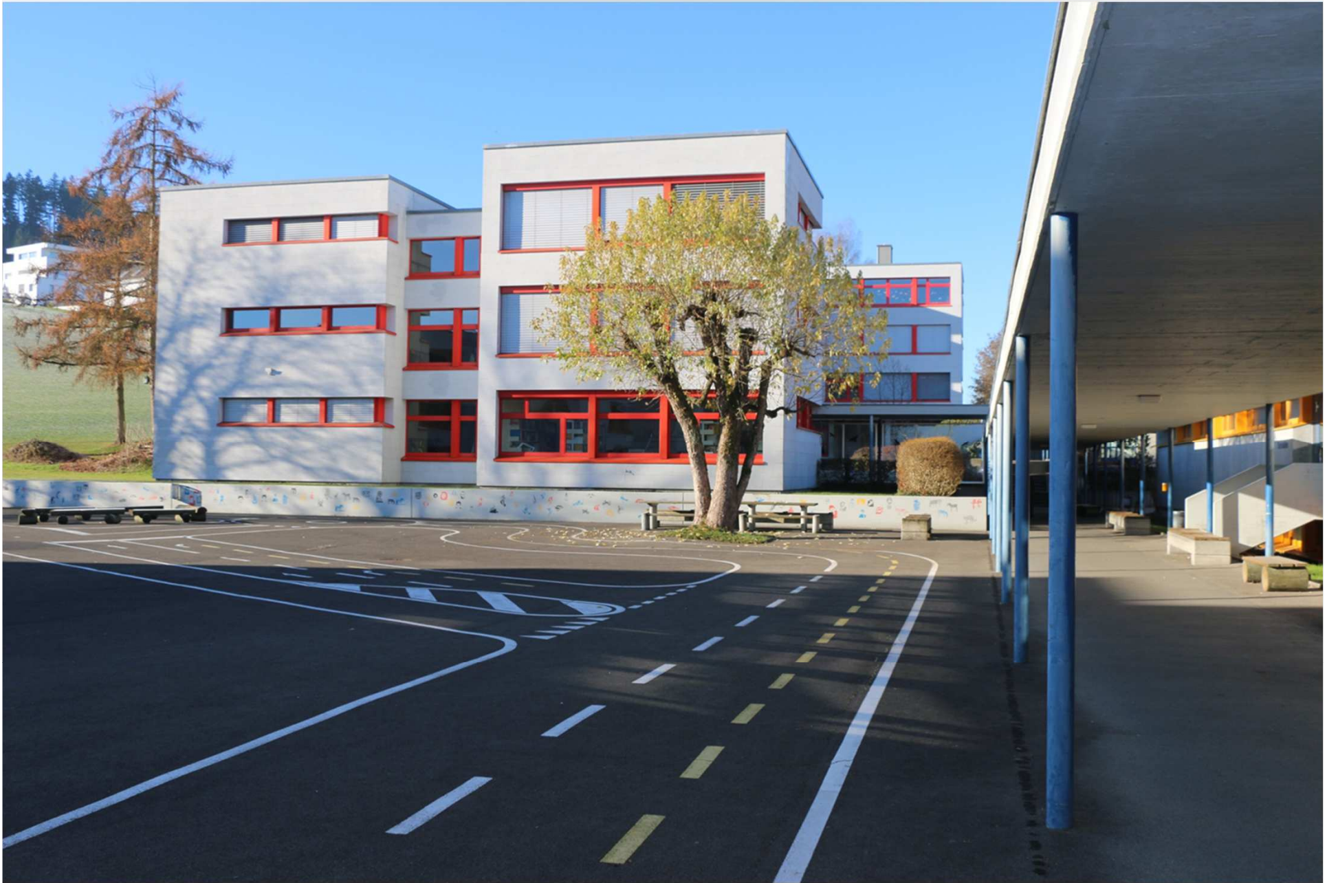
Trakt C und Lehrerzimmer / Turnhallen
