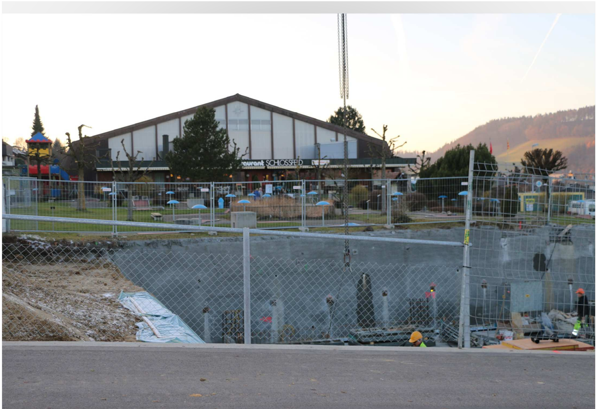
Freizeitzentrum mit der Baustelle für das bed&sport
